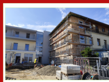
Pohled na přístavbu a původní budovu
