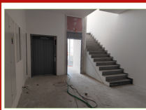
Schodiště a výtah z přízemí
