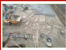
Pokládání základové desky
